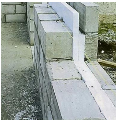
Рис. 1. Многослойная конструкция из газобетона
